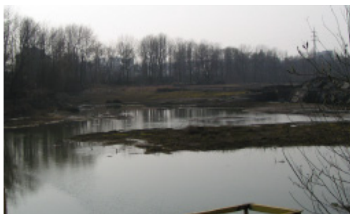
Obr. 11: Dokumentační fotografie kaliště v blízkosti Třebovické elektrárny
