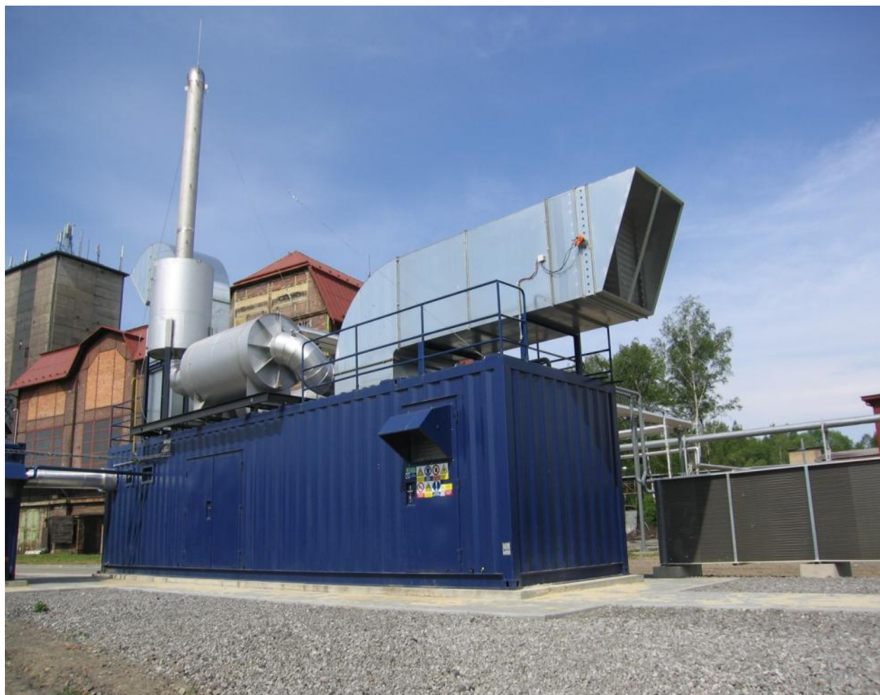
Fig. 6 Cogeneration unit QUANTO D 1200 SP NOC.
